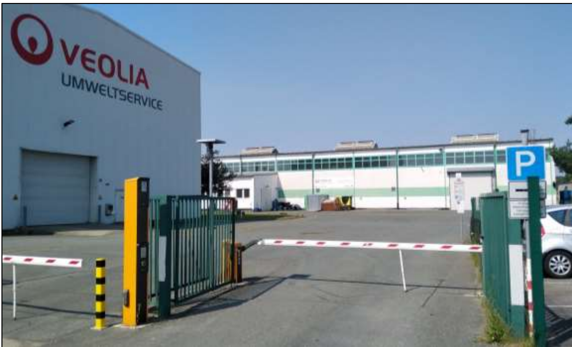
Abbildung A-2 – Deponiefläche im Untersuchungsgebiet „Gewerbestandort“ (Standpunkt: mittig im Untersuchungsgebiet, Aufnahme in Richtung Nordost)
