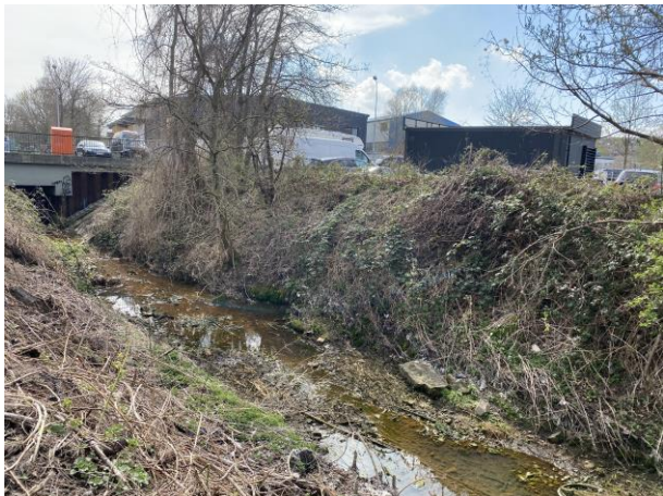
Abbildung 2-3: Westliche Böschung unterhalb des Einlaufbauwerks, nördlich der Straße „Am Kayenmühlengraben“
