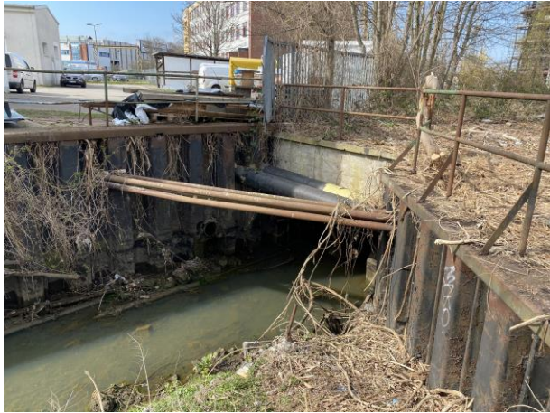
Abbildung 2-1: Einlaufbauwerk am Übergang vom offenen zum verrohrten Gewässerabschnitt
