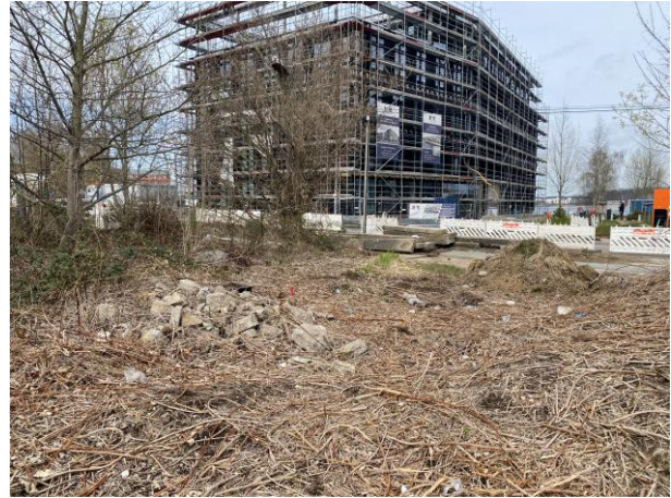
Abbildung 2-2: Bereich des verrohrten Gewässerabschnitts nördlich des Einlaufbauwerks. Im Hintergrund liegt die Kurt-Dunkelmann-Straße.
