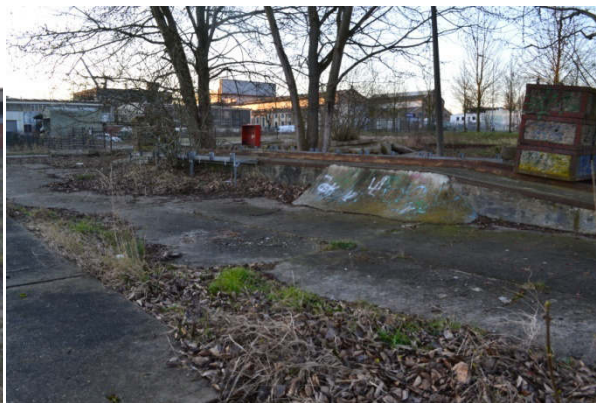
Foto 11: Betonboden und Rampe
