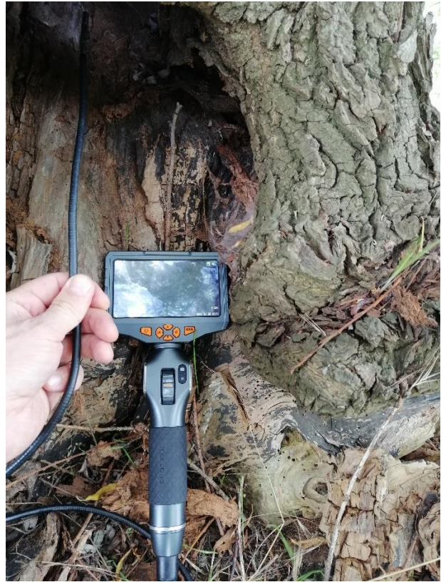
Abbildung 10: Überprüfung mittels Endoskop
