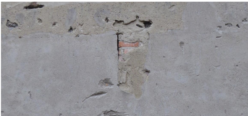
Abbildung 9: Detailaufnahme des (nördlichen) Spalts im Mauerwerk von Gebäude 55a.
