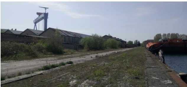
Hallen und Kaiflächen parallel zum Werftbecken
