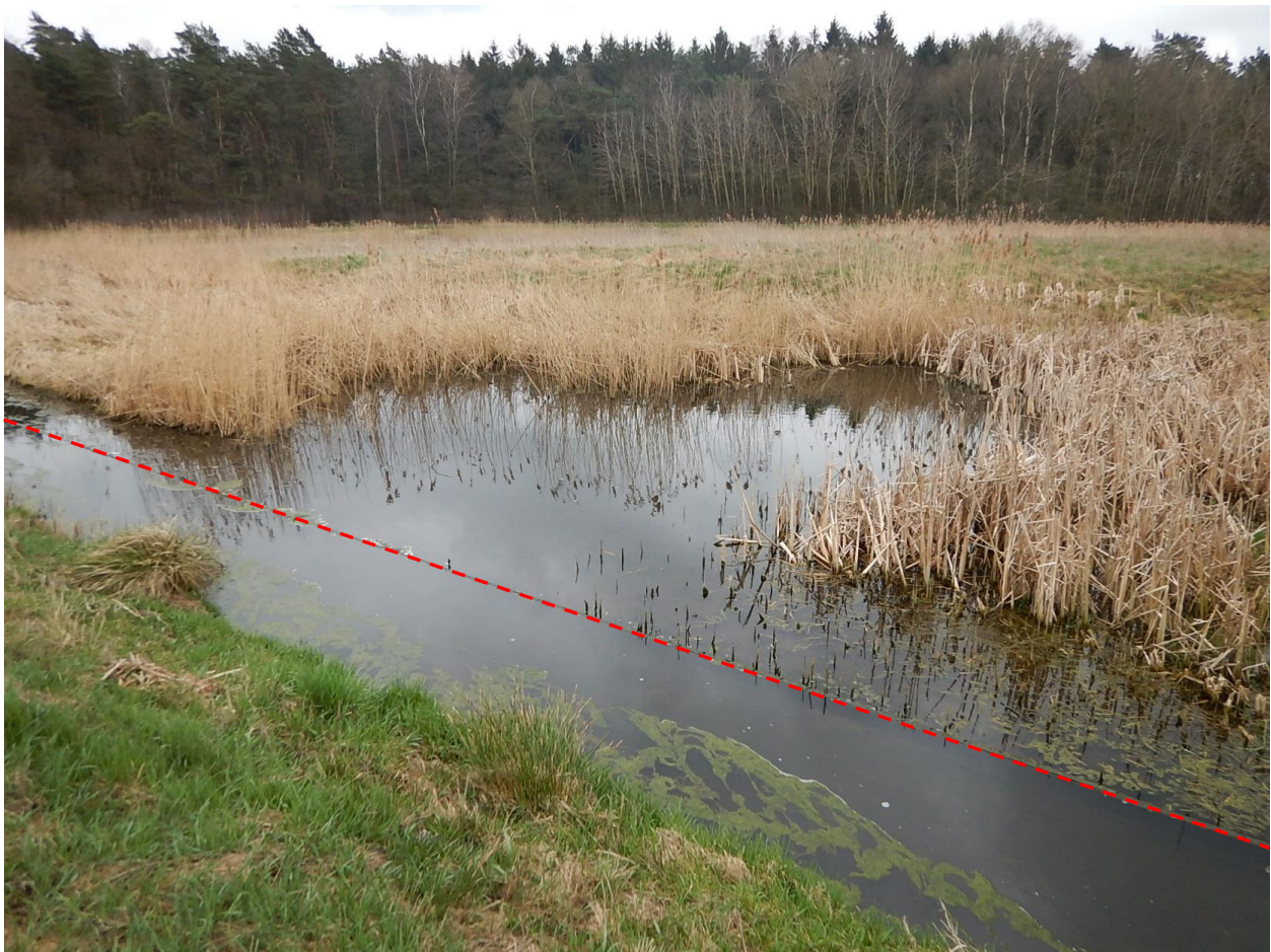
Abbildung 7-14: Erfolgte Einlaufgestaltung mit horizontaler Überlaufkante in das künstliche Feuchtgebiet unterhalb der Kläranlage Neukloster (rote gestrichelte Linie = Überlaufkante), eigene Aufnahme
